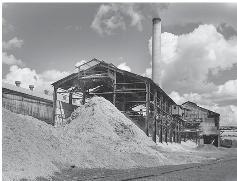
Con el funcionamiento del turbo-condensante, bajó la loma de bagazo, cuyo exceso puede detener la producción de azúcar.
