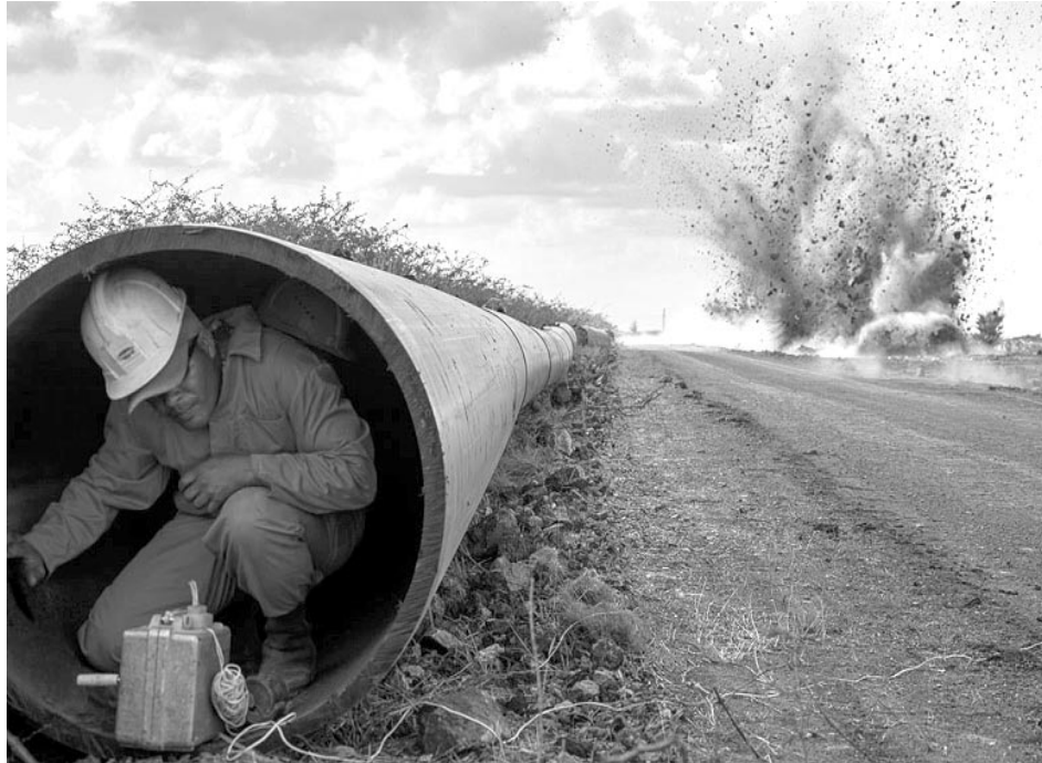
Gracias a la brigada de voladuras de la Empresa Explomat, el trabajo en la conductora avanza.
