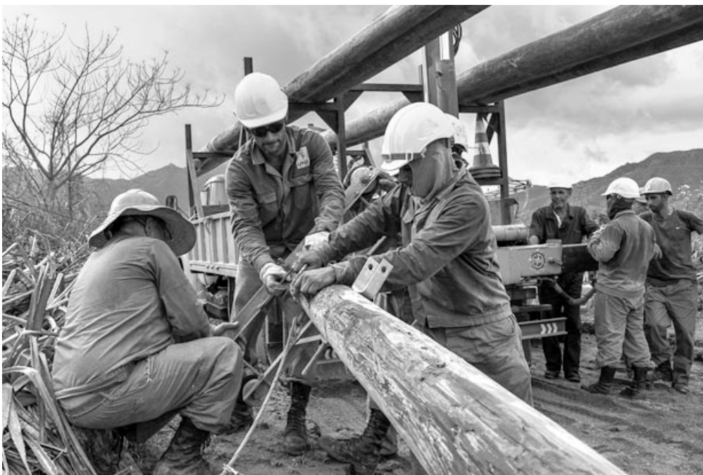
Con la ayuda de la grúa Toimil, un equipo de linieros puede instalar hasta cinco postes en una jornada.
