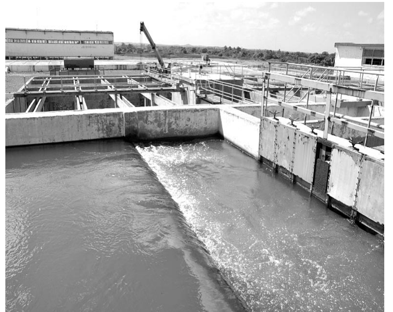
La Ecoia-8 inicia las reparaciones que darán vida al tercer decantador de la Potabilizadora, que puesto en funcionamiento lograría procesar los 1 800 litros por segundo que tiene de capacidad total la planta de tratamiento.
