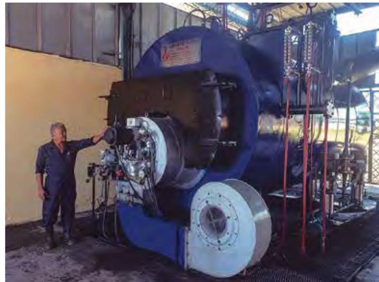
Con la puesta en marcha de la sala de caldera eficiente de la Unidad Empresarial de Base Empacadora Raúl Cepero Bonilla se logra una disminución en el consumo de combustible en más de un 37 % en comparación con el anterior equipamiento, unido a superiores resultados productivos en esa planta de la industria cárnica.
