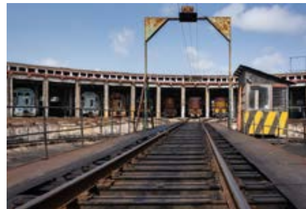
Casa redonda de los talleres ferroviarios de Camagüey, interesante lugar de la arquitectura industrial en el país.
