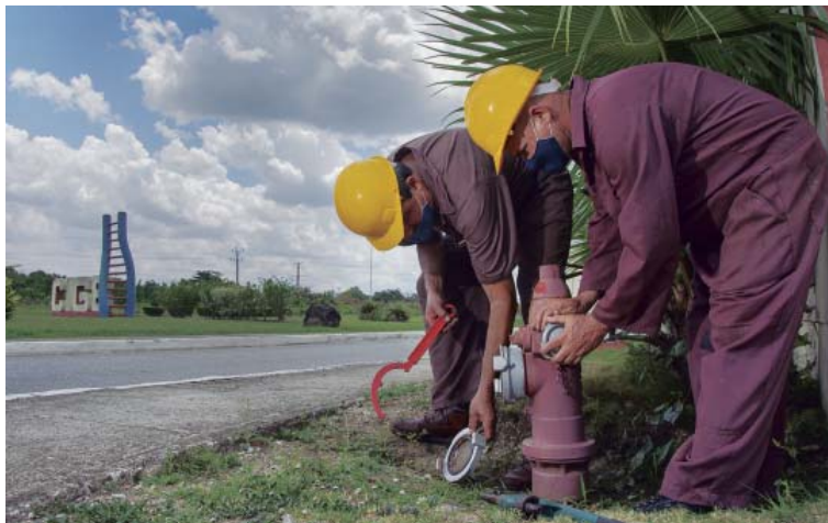
Con el mantenimiento sistemático a los hidrantes, el CIGB garantiza el acceso al agua en caso de que ocurriera un siniestro.
