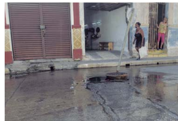
Según los vecinos este salidero en la calle Lugareño, entre San Clemente y San Rafael, lleva años dando problema y no acaba de solucionarse.
