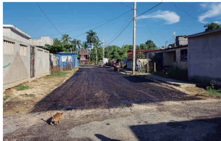
Avanza la reparación de calles, antes intransitables.
