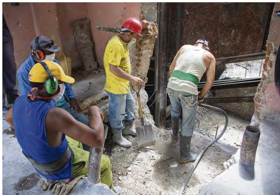
Trabajos en la fundición de las bases uno y dos de las cuchillas del basculador. Disponen de un solo martillo neumático, pero con doble turno lo aprovechan al máximo para nivelar el viejo hormigón armado.
