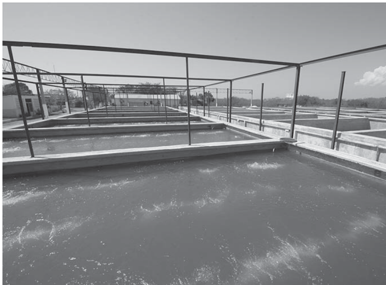
En el área de precría tienen una capacidad instalada de 32 tanques que representan 70 m 3 , aunque actualmente son solo 16 los utilizados.
