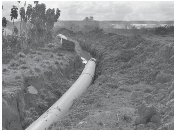
No se detiene la colocación de la nueva conductora Pontezuela-Potabilizadora de Camagüey, de 800 milímetros de diámetro, desde la ciudad hacia el embalse y viceversa.
