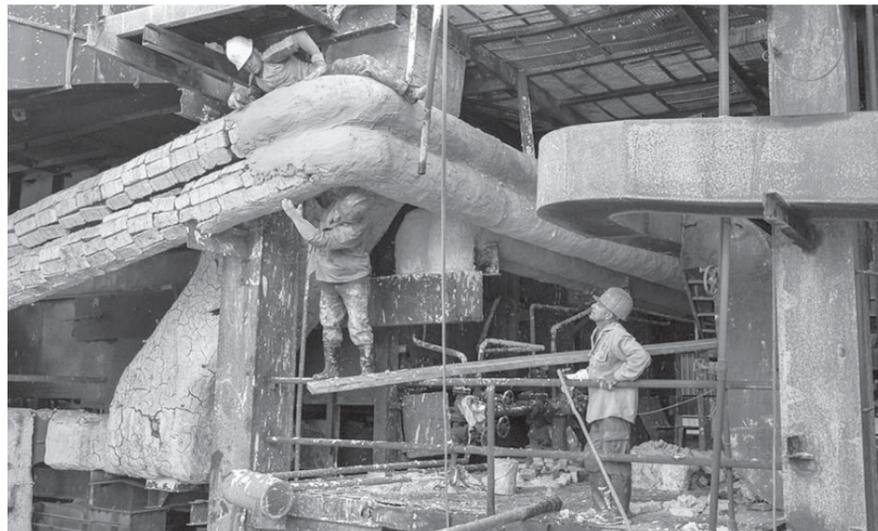
La generación de vapor, línea central en la producción azucarera, precisa de la preservación de las tuberías con amianto.
