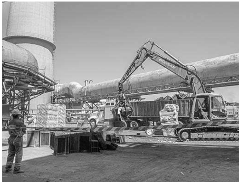
Con la llegada de los aseguramientos fue posible acelerar los trabajos.
