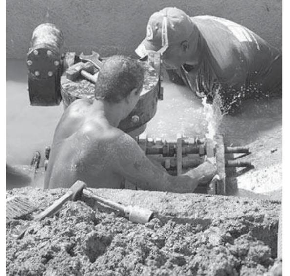
Un intenso trabajo ejecutaron las brigadas de la Empresa de Acueducto y del Instituto Nacional de Recursos Hidráulicos en Camagüey para, en solo 20 horas, reparar válvulas, corregir salideros en la conductora Cubano-Búlgara y adelantar los sifones del tercer módulo de la Planta Potabilizadora a cargo de la Constructora Número 2 del Micons, que mejorarán el servicio de agua a los consumidores de la capital agramontina.
