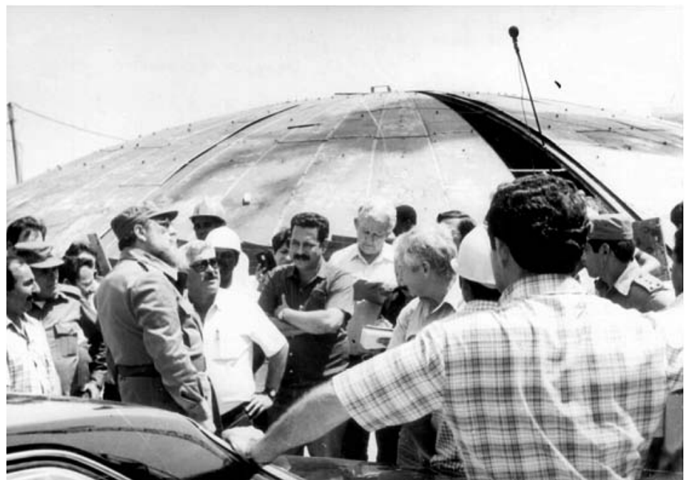
En la base receptora de amoníaco, en construcción.
