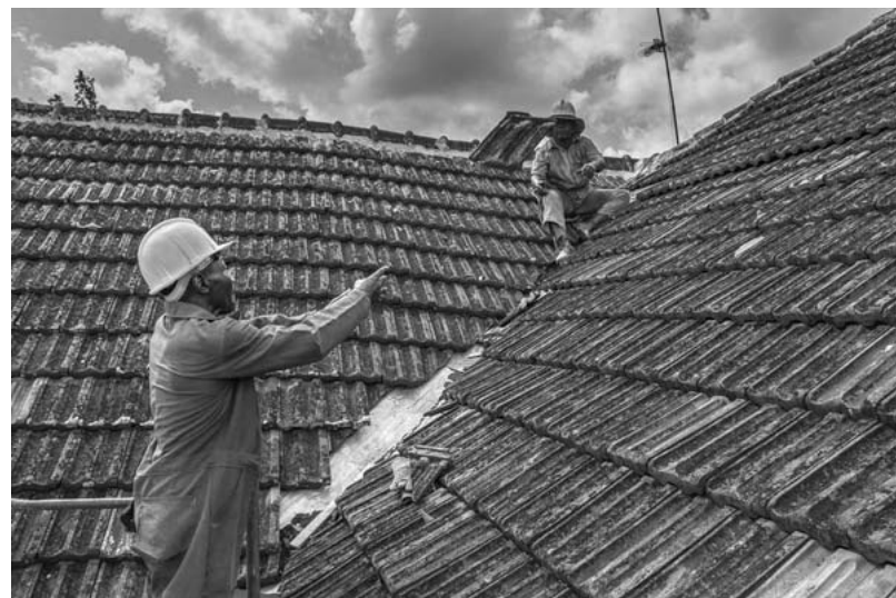
Las tejas francesas tienen dificultades técnicas para su colocación por lo que volverlas a colocar en su sitio resulta tarea compleja.
