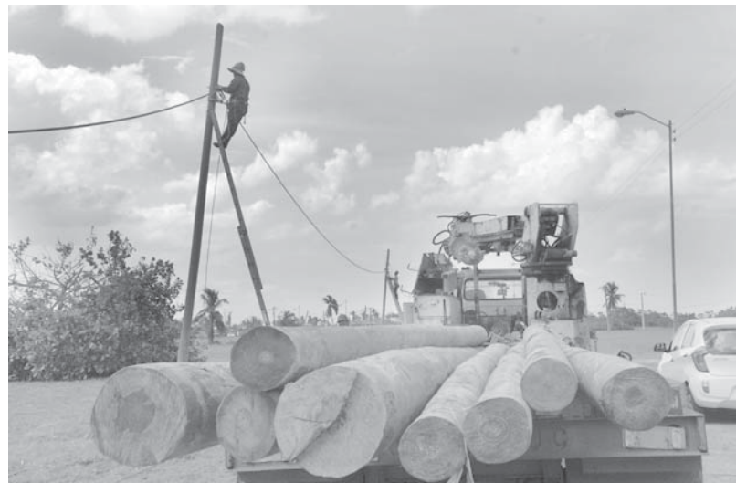
De inmediato la recuperación eléctrica y telefónica contó con linieros especializados para la sustitución de cables y postes.
